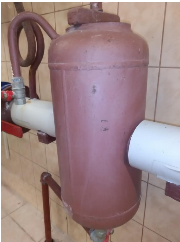
Fot.10. Pomieszczenie kotłowni – odmulacz siatkowy
