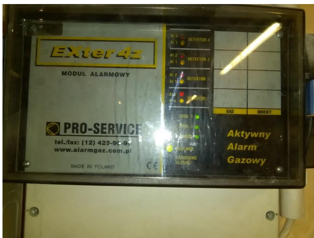
Fot.22. Pomieszczenie kotłowni – centralka detekcyjna
