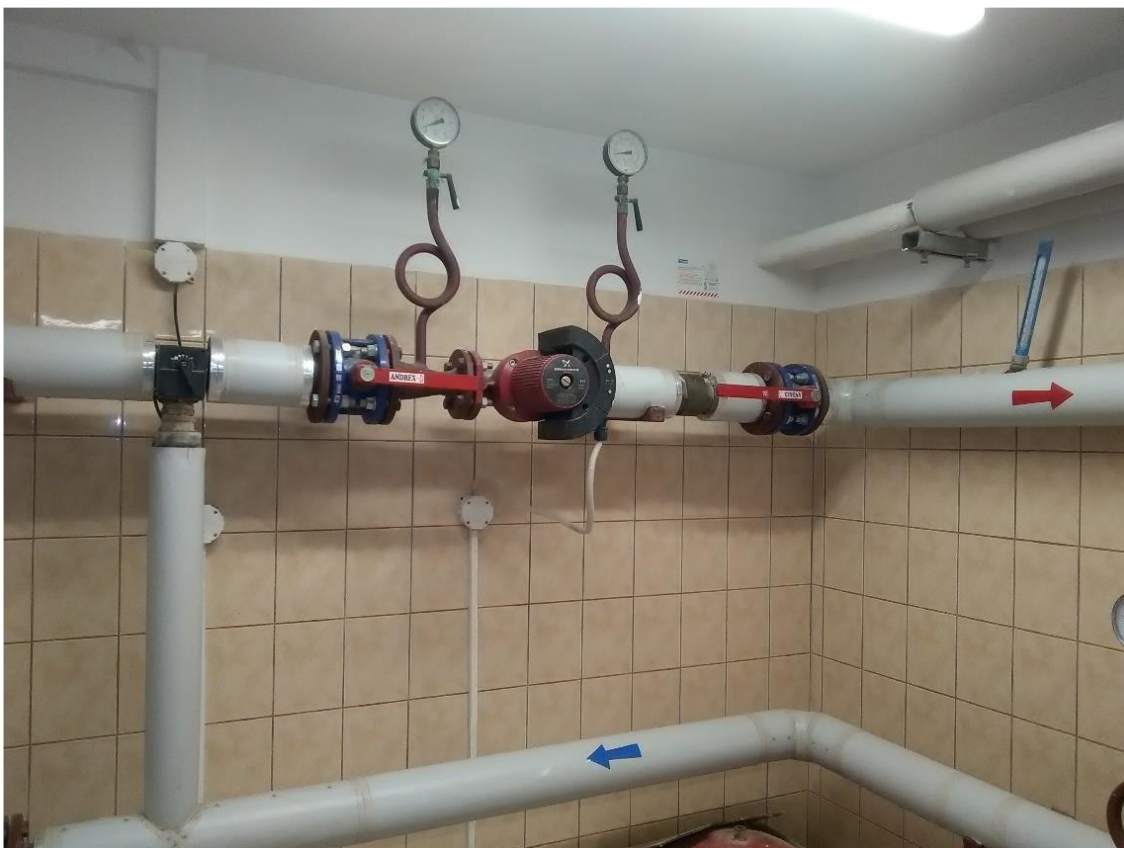
Fot.14. Pomieszczenie kotłowni – pompa
