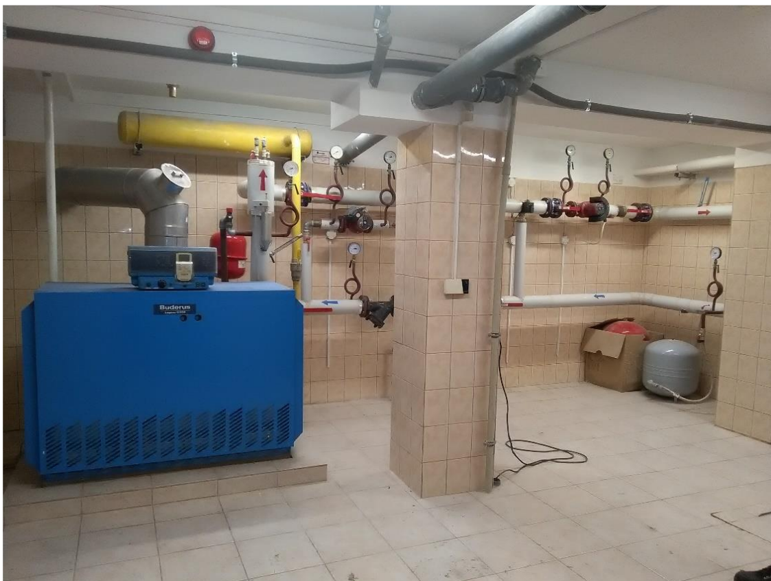
Fot.4. Pomieszczenie kotłowni – kocioł gazowy
