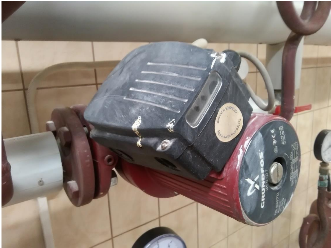
Fot.12. Pomieszczenie kotłowni – pompa obiegowa
