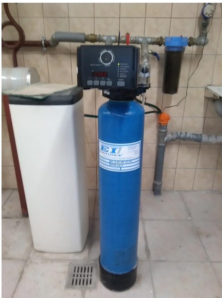
Fot.20. Pomieszczenie kotłowni – filtr do wody
