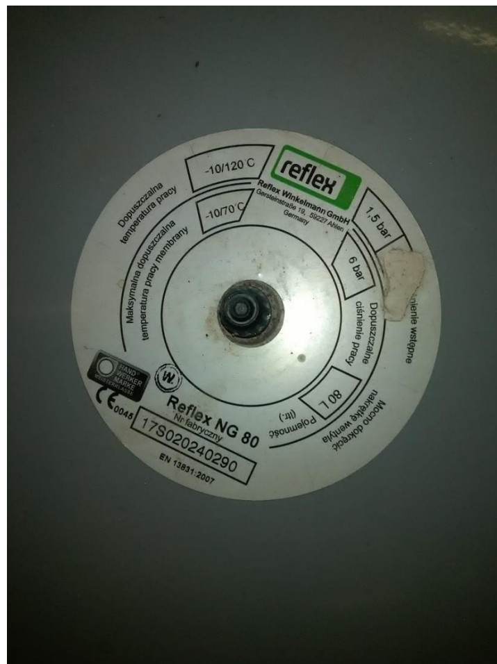
Fot.16. Pomieszczenie kotłowni – dane techniczne pierwszego naczynia zbiorczego
