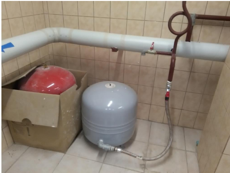
Fot.16. Pomieszczenie kotłowni – dane techniczne pierwszego naczynia zbiorczego
